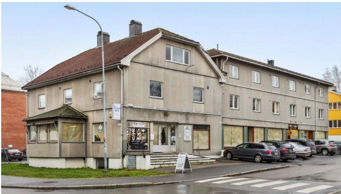
Skoleveien 2 hvor opprinnelig volum til venstre både er påbygget og fasadeendret. Tilbygget ses til høyre.
