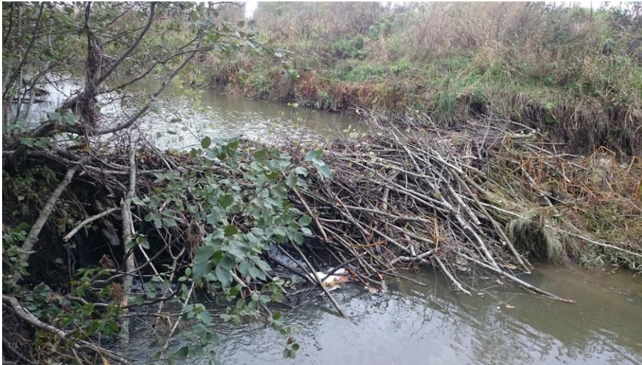
Figur 5: Demning i Krokstadelva (punkt 13 i figur 3b).
