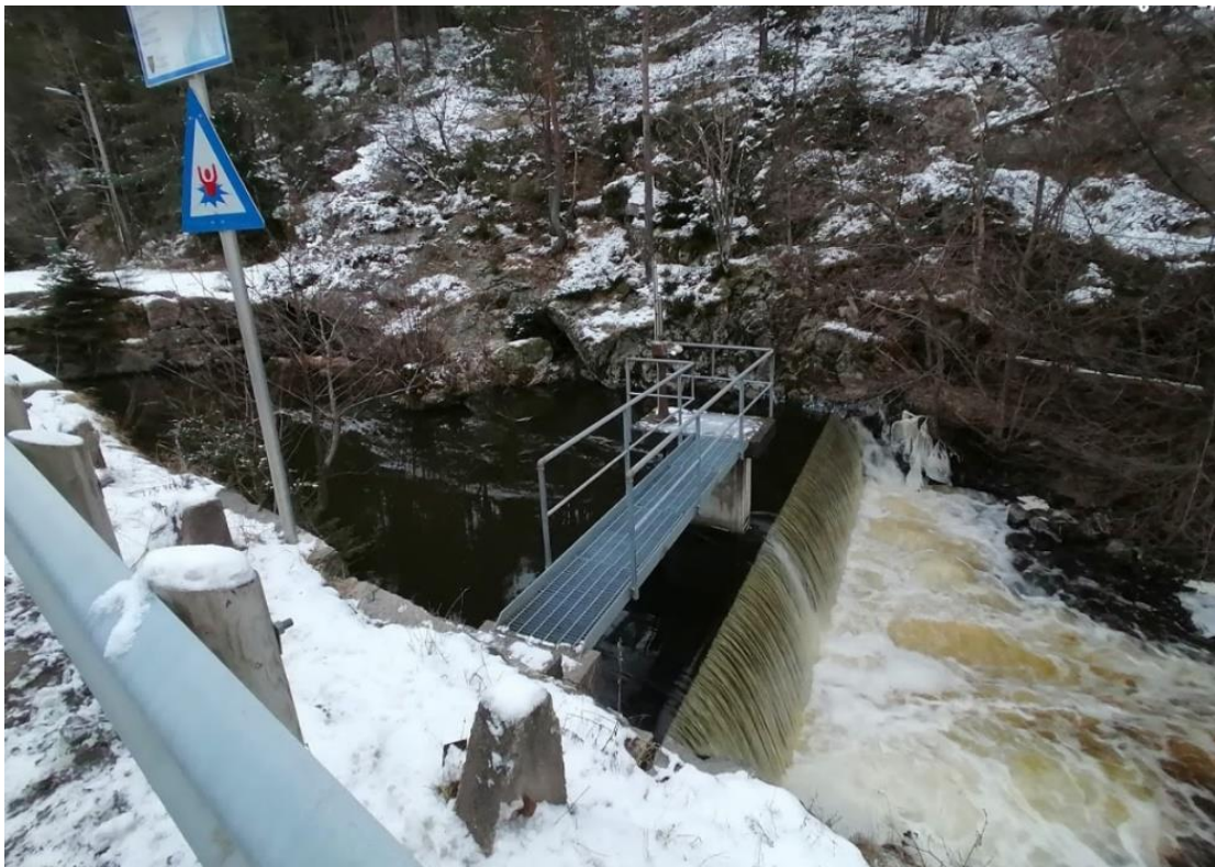
Figur 6 Utløpsdam i nordenden av Gjersjøen
