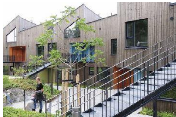
Bebyggelse langs Sagaveien skal ha sammenlignbar skala som etablert bebyggelse i området, skånsom materialbruk og forhager. Eksempel fra Furuset.
