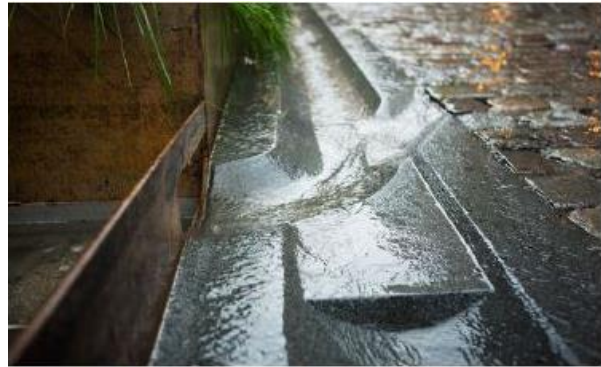
Eksempel på åpen overvannshåndtering i veianlegg. Deichmanns gate i Oslo sentrum.
