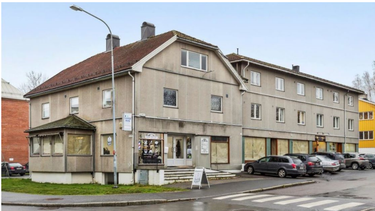
Skoleveien 2 hvor opprinnelig volum til venstre både er påbygget og fasadeendret. Tilbygget ses til høyre.
