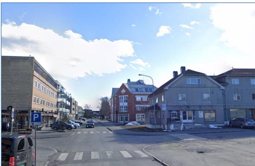
Figur 7 Gangfelt over Moerveien/Raveien og Skoleveien, i retning sør (kilde: Google Maps Street View)
