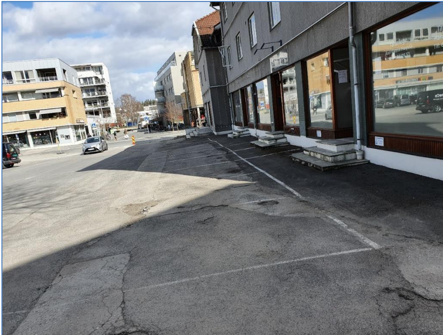
Figur 4 Kundeparkering ved Skoleveien 2 (bilde: Sweco Norge AS)
